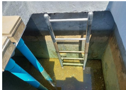
ถังเก็บน้ำสำรองชั้นดาดฟ้า
